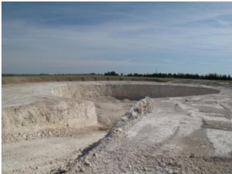
Figure 5 : Exemple d'excavation d'une fondation d'éolienne (Parc éolien de l'Herbissonne Source : Etude d'impact du parc Maison Dieu)
